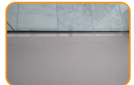
Las piezas de los bordes llenan los huecos a lo largo de las paredes.
