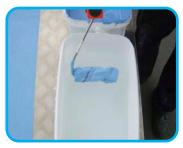
6. Después de la aplicación, lave a fondo con agua fría los rodillos y cualquier otro equipo que se haya utilizado.
