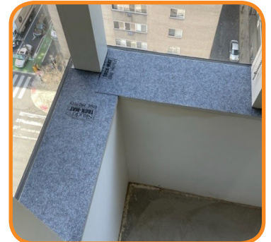
Proteja los bordes de los daños
