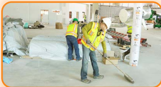
Barra a fondo la superficie para asegurarse de que el área esté limpia y libre de escombros/materiales extraños que comprometan y contaminen la capa base.
