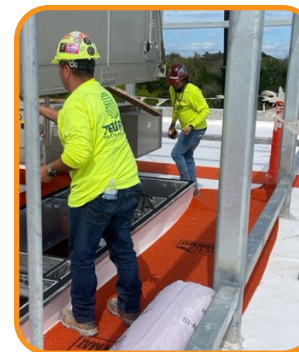
Tránsito seguro en el lugar de trabajo.
