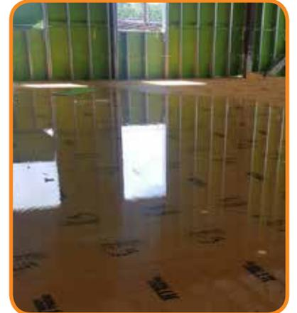
Si el área está inundada, retire el agua y deje secar durante 24 horas antes de usar la máquina.
